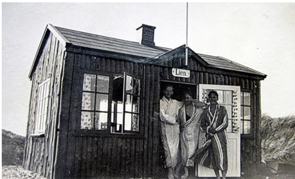
Lien ca 1933 med 3 strandløver, min far t.v. Gavlen stod intakt inde i en skillevæg, da vi byggede om for mindre end tyve år siden.
