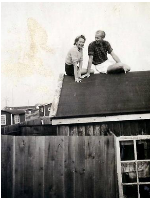
Mine forældre "bager" på taget. Plankeværket i forgrunden afskærmer indgangen til vores "luksusdas"
